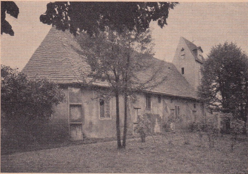
Die evangelische Kirche zu Eisbergen vor der Neueindeckung im Jahre 1952 mit dem alten Dach aus Sandstein=(Höxter)=Platten
